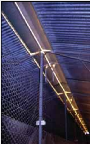
El techo de plancha metálica termina en un lucernario. Una malla metálica y un tabique inferior dividen cada gallinero en dos mitades iguales, capaces de alojar unos 1.300 pollos cada una. La imagen superior corresponde al inicio de la cría de un nuevo lote de pollitos en una de esas mitades.
