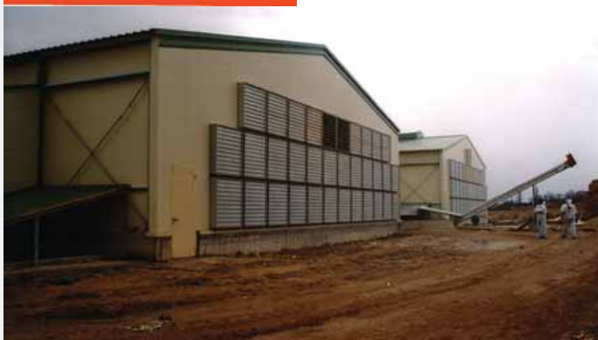
Extremo de las naves de puesta en el que se hallan instalados los ventiladores, con uno de ellos en funcionamiento en el momento de la foto.
