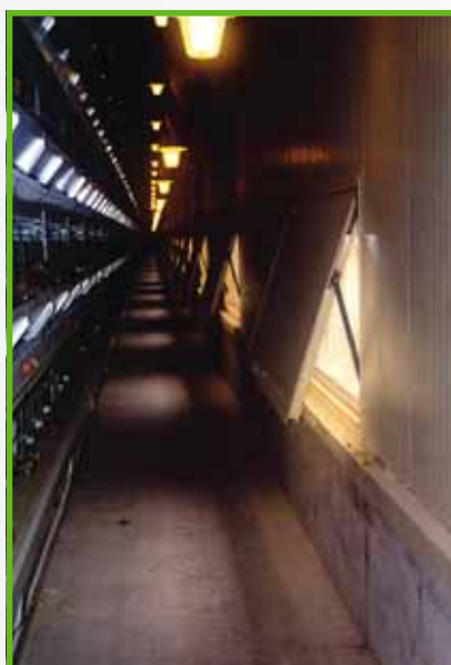
Las trampillas de emergencia, abiertas, en una demostración de su funcionamiento.
