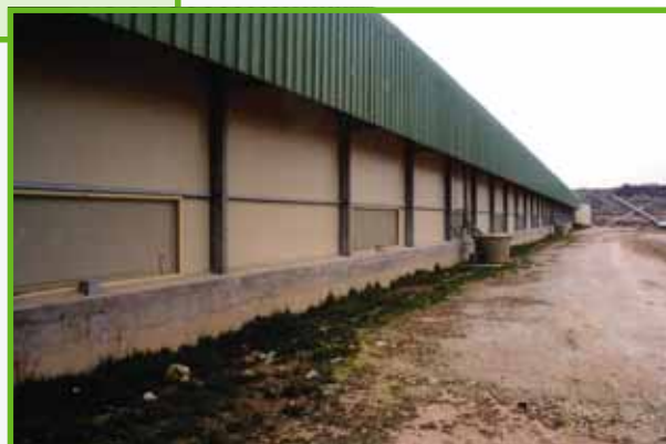
Fachada de una nave, mostrando el faldón que protege a los paneles de refrigeración y las trampillas de emergencia.
