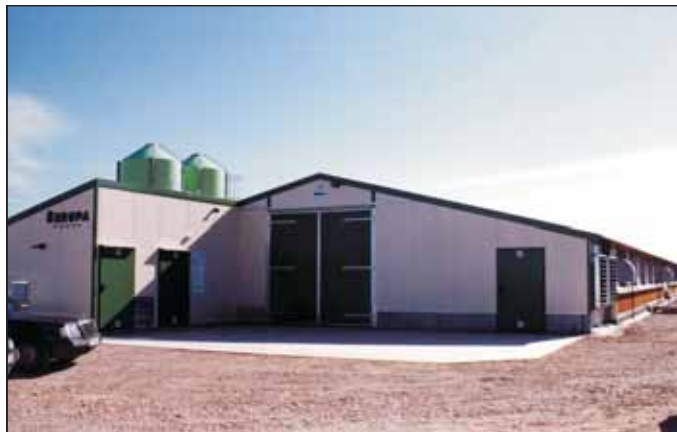
El llamado «almacén técnico», en la entrada de la nave, es muy conveniente para centralizar muchas operaciones (ordenador, medicaciones, botiquín, etc.)
