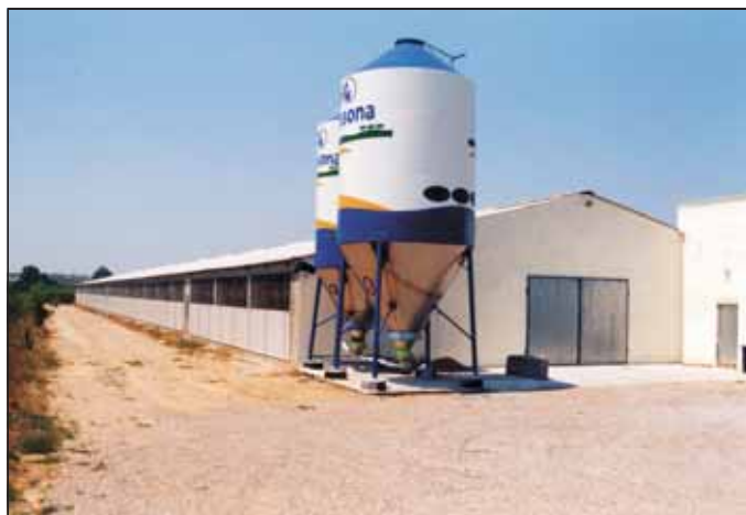
Un par de silos en las granjas de broilers son algo casi obligado actualmente, para prever una máxima elasticidad con el aprovisionamiento del pienso de retirada.
