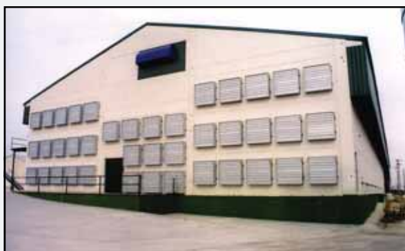
El gallinero de Padrino Vilela recién inaugurado, en el muro piñón por el que se realiza la extracción de aire en funcionamiento túnel.
