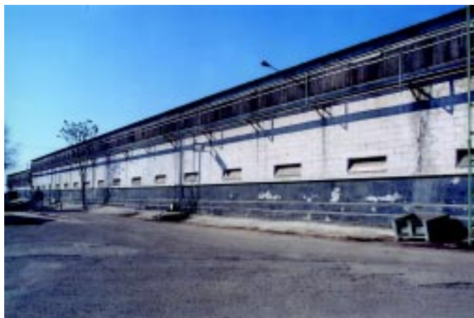
Fachada de una nave de Avícola Padrino, con las entradas de aire inferiores, para invierno, y los paneles frente a las superiores, para verano.
