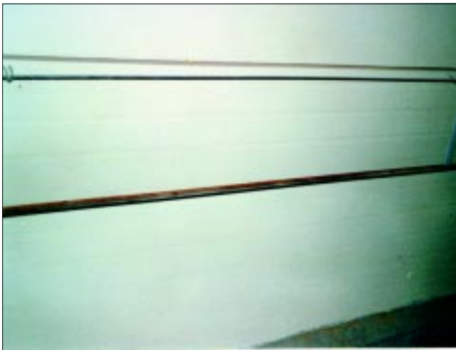
Apertura auxiliar en una de las paredes laterales utilizada en caso de fracaso eléctrico.
