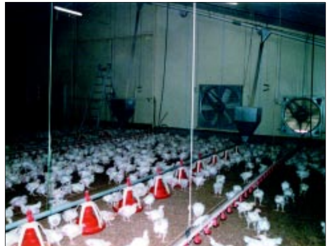
Detalle de los ventiladores que realizan el movimiento forzado del aire .
