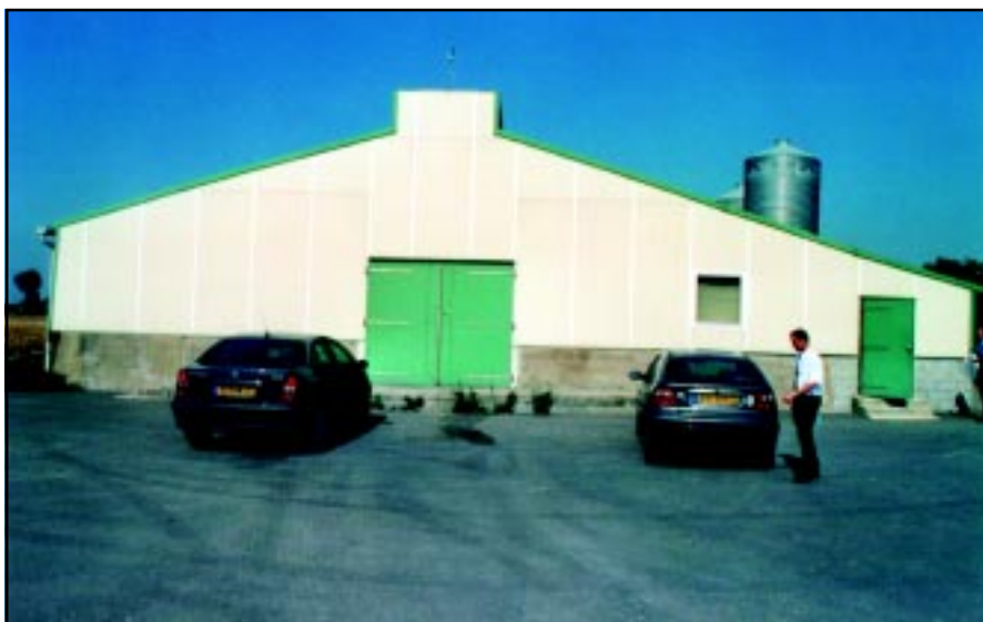
Vista exterior de la nave, aparentemente asimétrica por tener en el costado derecho el departamento sanitario.
